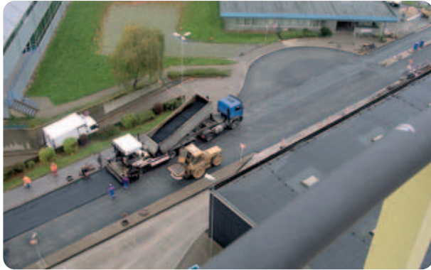
EUROVIA-Geräte im Einsatz beim Einbau von Microvia®
