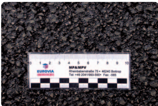
Nahaufnahme vom eingebauten Microvia®
