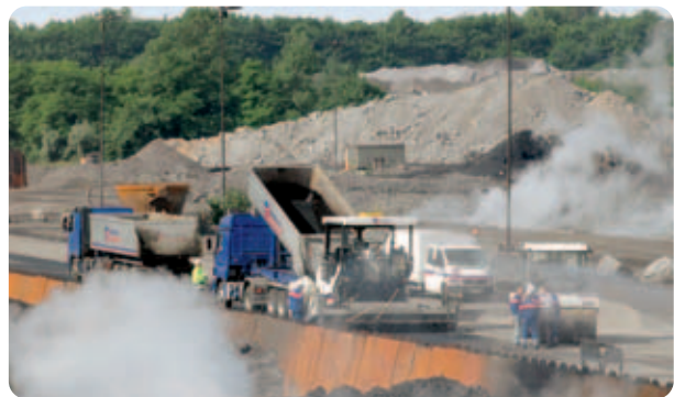
Einbau der Hochleistungsasphalte bei laufender Produktion
