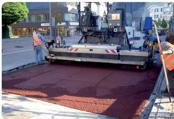
Auf die Asphalttragschichten erfolgt der Einbau von MICROVIA® 0/8 rot
