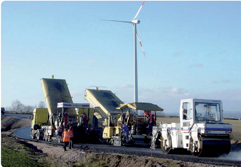
Asphalt-Einbau innerhalb einer Woche an der Baustelle S286 westlich Mülsen, 1.BA
