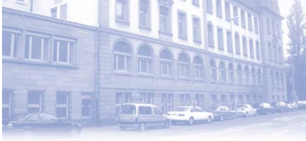
Rückbau Bundesbahndirektion Frankfurt
