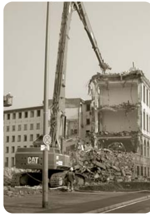
Rückbau mit Longfront-Bagger. Blick von der Hohenstauffenstraße nach Norden in Richtung Friedrich-Ebert-Anlage
