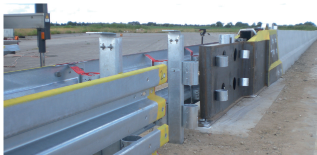
EURO-RACCORD® SR-Eco nimmt die Anprallenergie von Pkw und Schwerlastfahrzeugen optimal auf.
