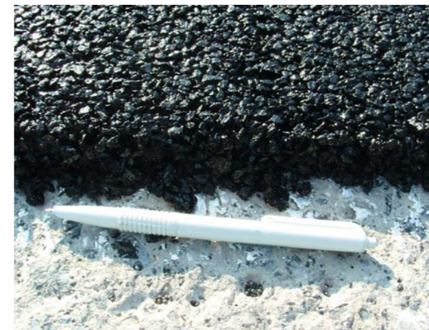
Offenporiges Asphalttraggerüst auf der Fahrbahntafel. Die Betonoberfläche, hier gut sichtbar, wurde vorher gefräst und kugelgestrahlt.
