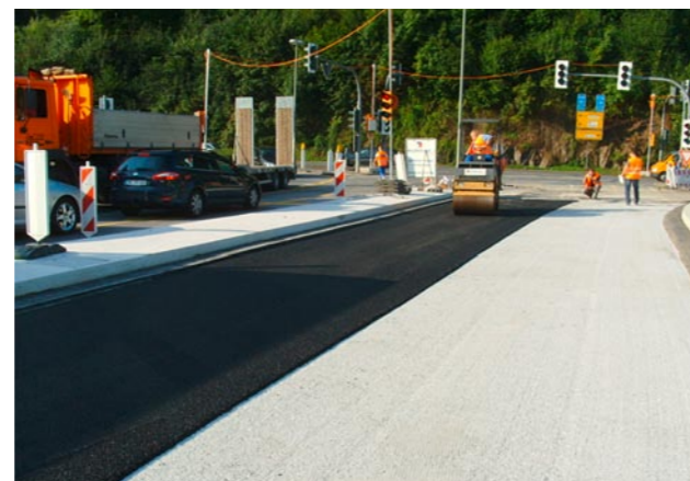
Einbau des offenporigen Asphalttraggerüsts.
