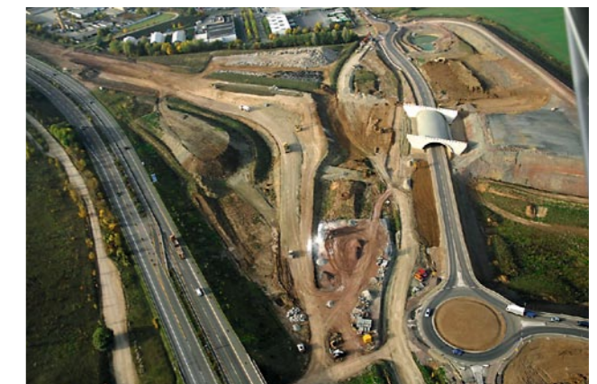
Die Luftaufnahme zeigt den Bau eines Anschlussbereiches.
