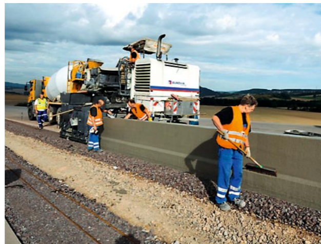
Das Betonieren der Betonschutzwände geschieht mit größter Sorgfalt.
