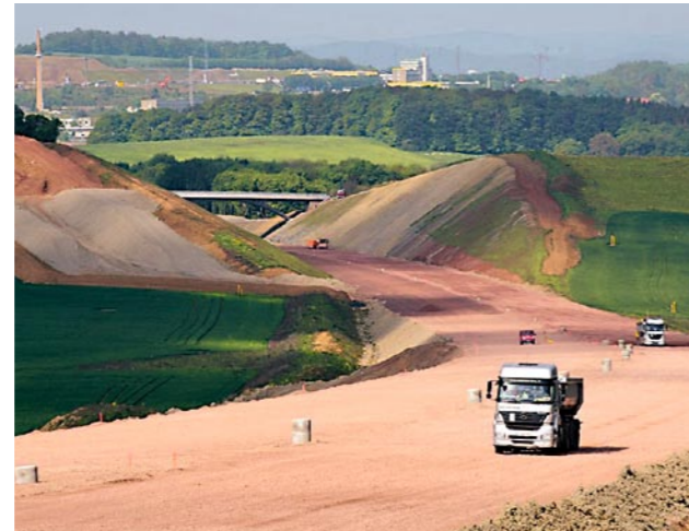
Dieses Foto lässt erkennen, welche großen Erdbewegungen nötig waren.
