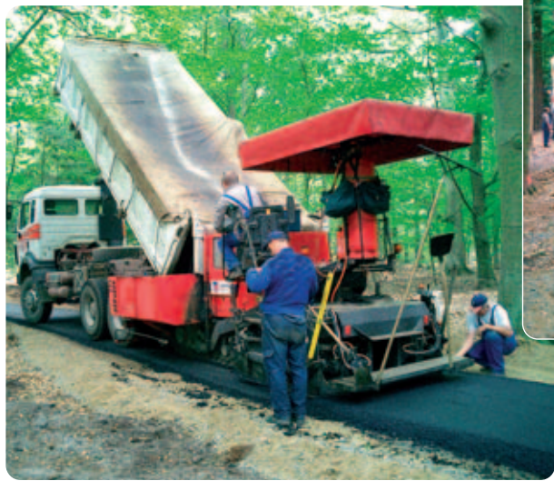
Einbau mit einem Kleinfertiger
